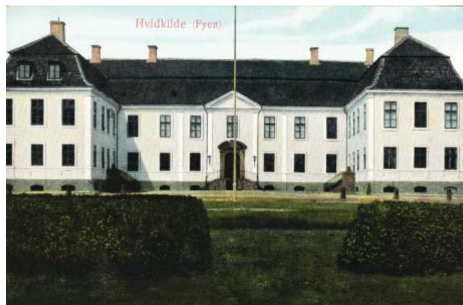
Figur 7. Hvidkilde herregårds hovedbygning, populært kaldet "slottet". Ingrid sad på kontoret bag det tredje vindue i stueetagen til højre for hoveddøren
